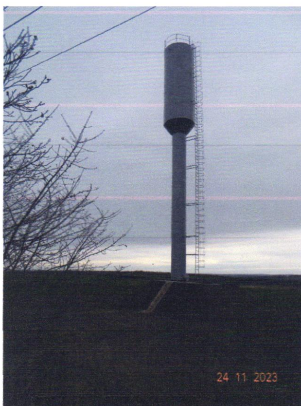
Platforma G: Alexandru cel Bun - 1 turn cu V=50m^3 și H=15m .
